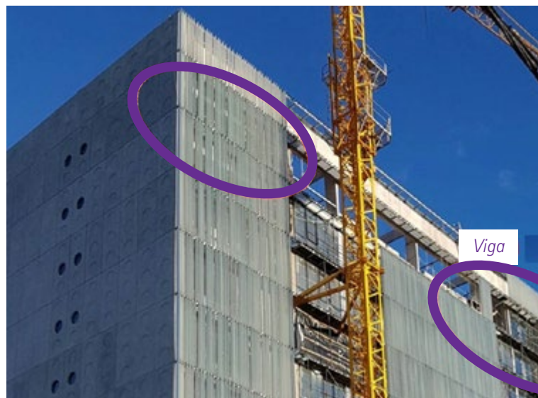
Figura 4 – Detalle piso 9, edificio durante la etapa de construcción
