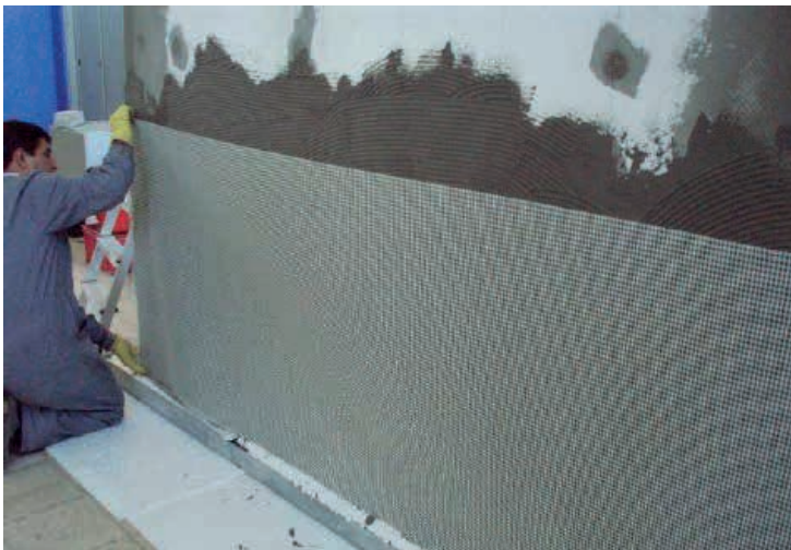
(a) aplicação de tela de fibras de vidro
